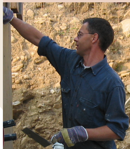
Johann beim Hausbau 2007
