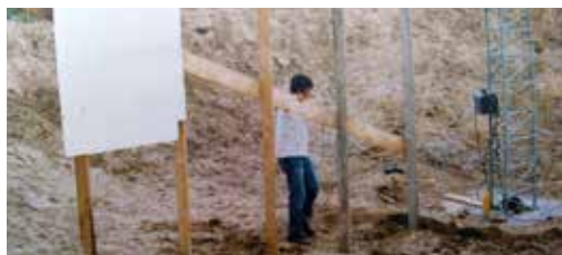
Bau einer Schablone für eine 33 m Reflektorantenne, 1996, Photo: Joachim Baur
